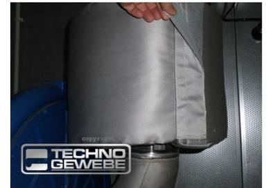
Hier sehen Sie, wie einfach und schnell 2 Ventile abisoliert und wieder isoliert werden. Bei Flanschisolierungen geht es sogar noch schneller!
